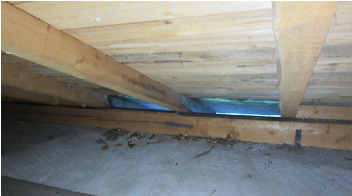
**Abbildung 3: Schlitzartigen Öffnungen zwischen den Fußpfetten**
