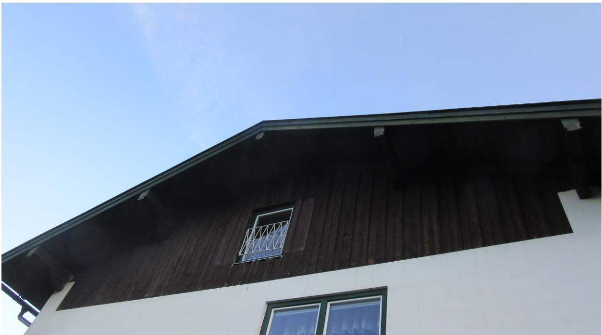
**Abbildung 6: Ohne vorspringende Lattung spaltenlos auf Mauerwerk aufsitzende Verschalung**
